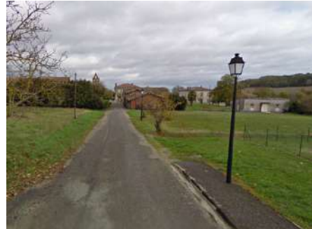
Axe desservant le lotissement le Barrounet et jouxtant la Mairie jusqu'à la RD 3
