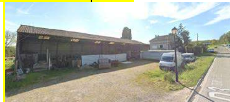
Hangar attaché à une habitation
